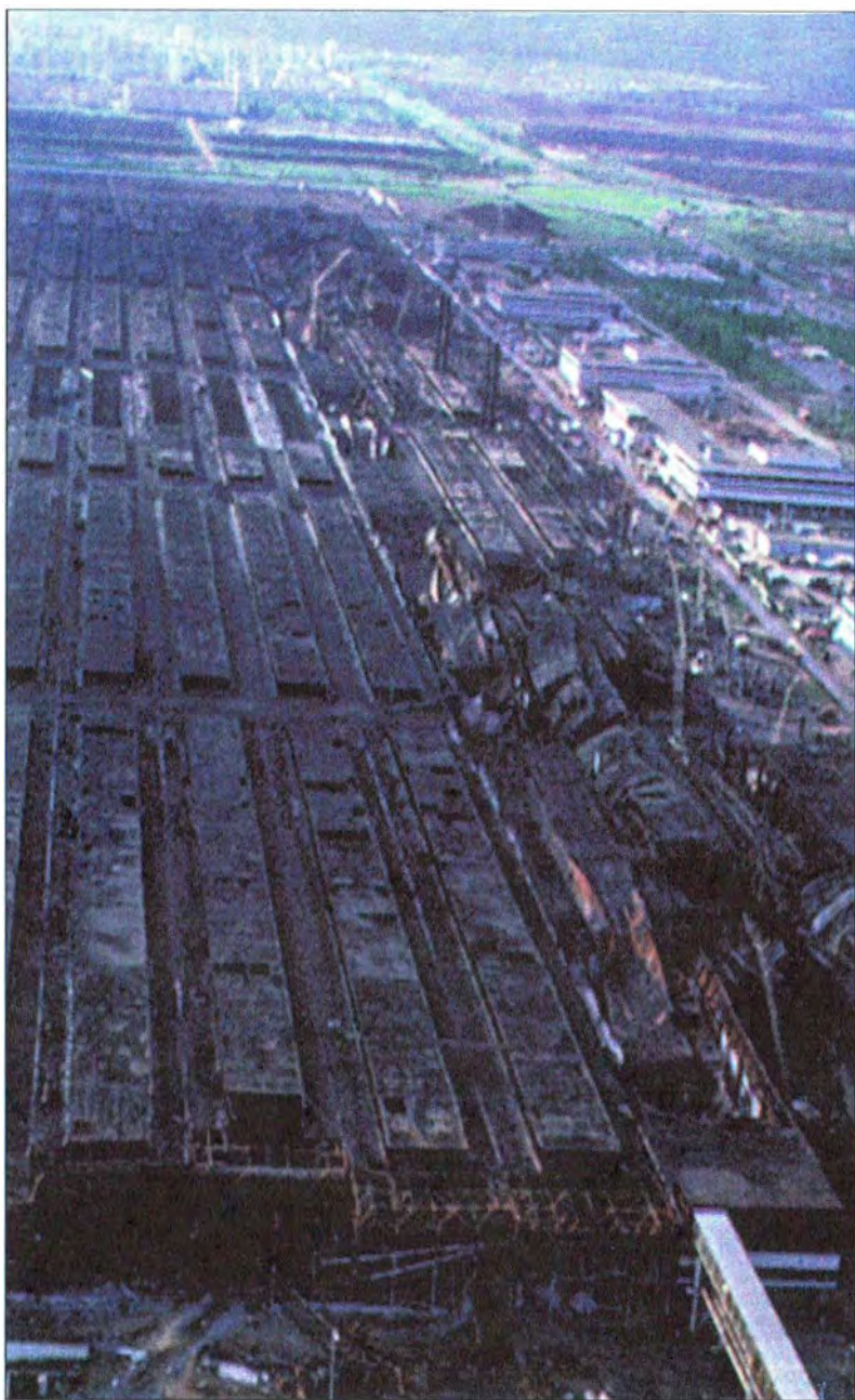
Последствия пожара на заводе двигателей АО «КамАЗ»
