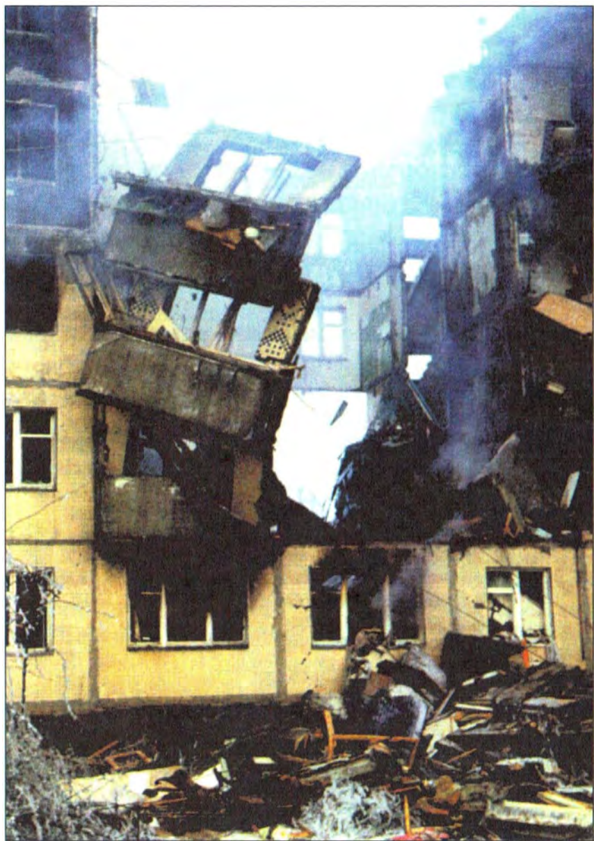
Последствия взрыва газа в жилом доме
